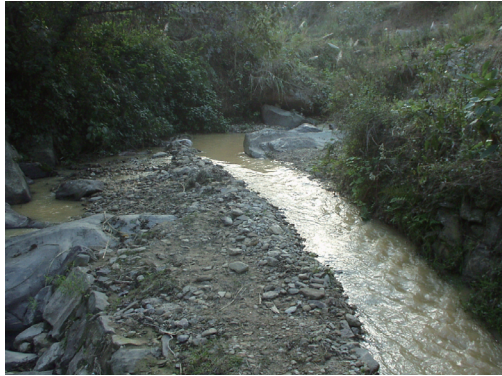
写真3 打碑寨溝の取水口。
