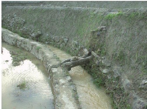
写真4 上流域のハニ族村を流れる打碑寨溝。 種を渡して田から田へと水を流す。打碑寨溝は上流域の多くの水源に対して水利権をもたない。水路を潜り抜けるように暗渠が掘られている箇所も多い。(2006年12月 筆者撮影)
