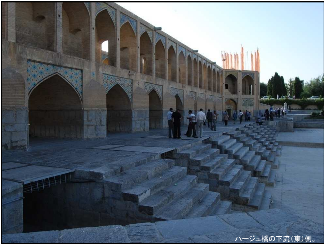
ハーजू橋の下流（東）側。
