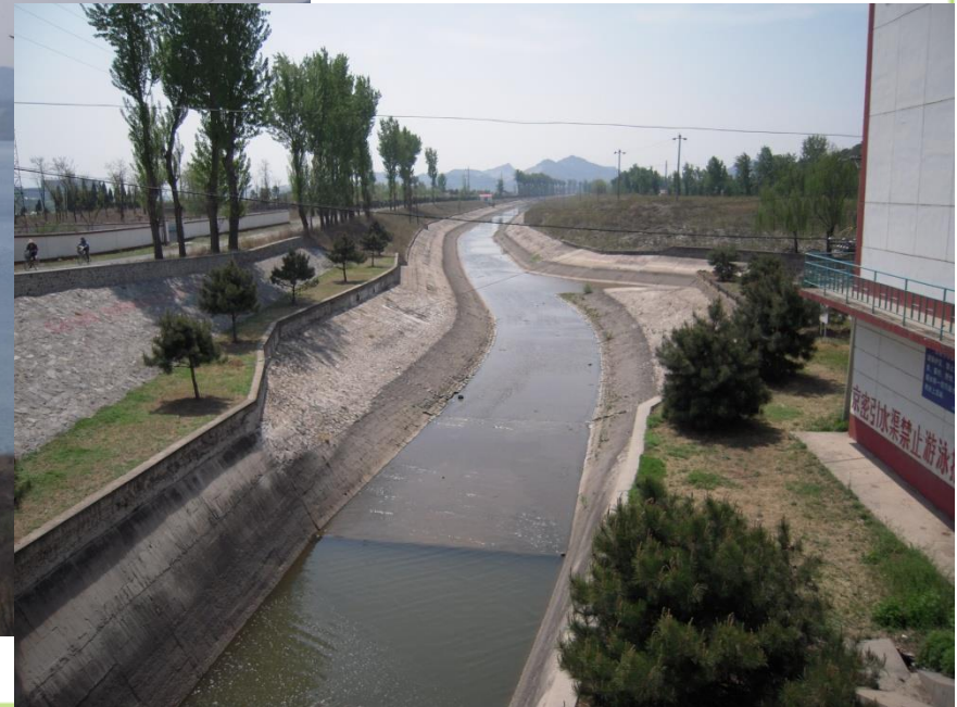
北京への導水路 京密引水渠
