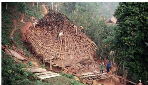
写真4 「亀の甲」型の家の解体
