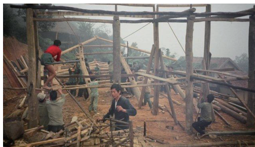
写真5 棟上げの様子
