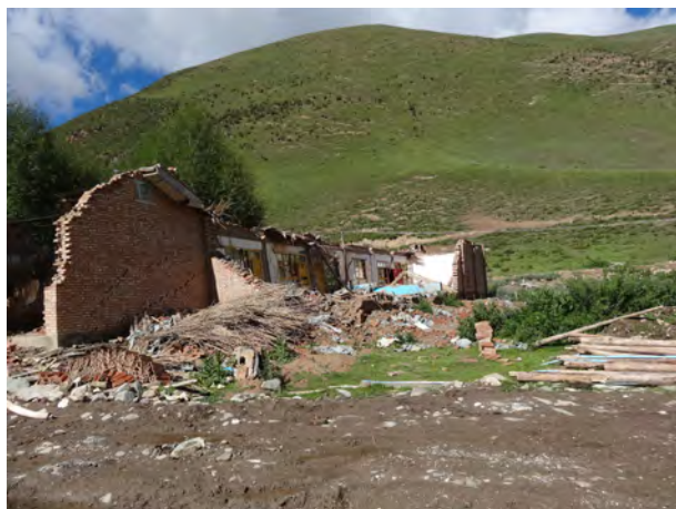
図 5. 地震で倒壊した建物
